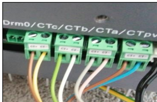
Figure 79 – Connexions des câbles CT pour les sondes de courant
