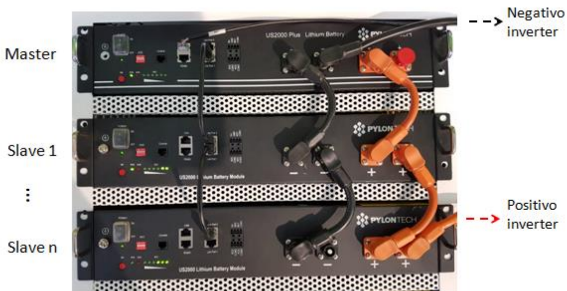
Figure 11 - Parallèle de trois batteries Pylontech
